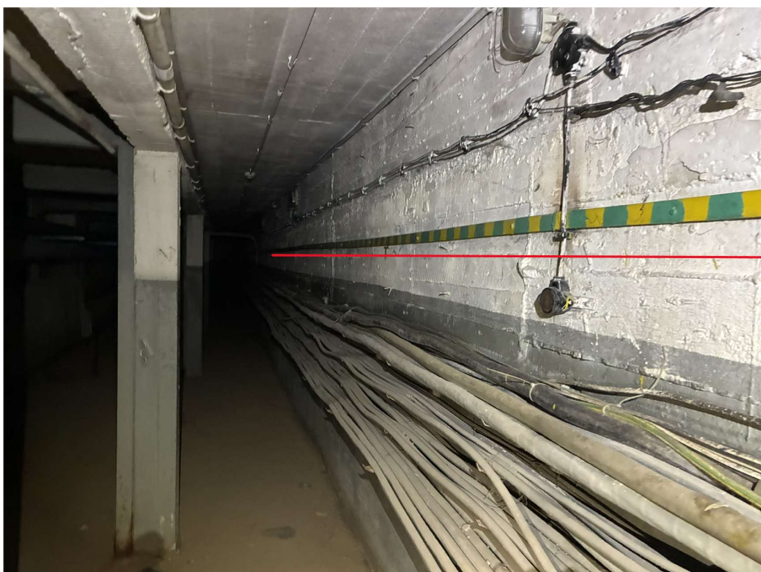
Zdjęcie 6 – Oznaczenie trasy rur prowadzonych w Kanale Technicznym.
