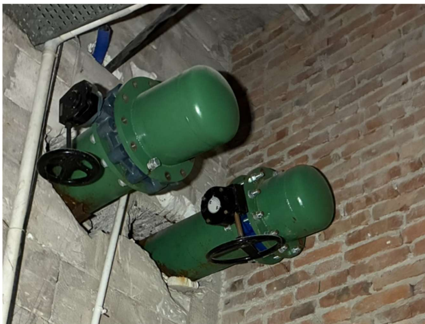
Zdjęcie 1 – Istniejące króćce rezerwowe instalacji ciepłego glikolu. Do tych miejsc nastąpi włączenie nowych rurociągów. Konieczna weryfikacja średnic i sprawdzenie sprawności przepustnic. Króciec lewy zasilanie. ; króciec prawy powrót.
