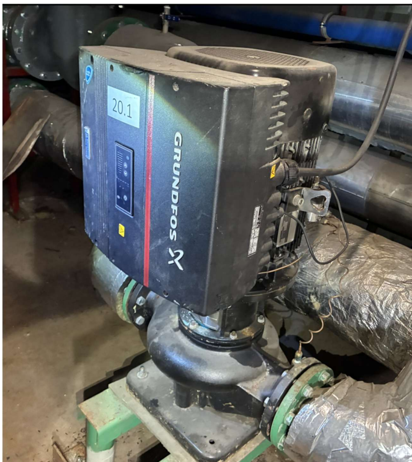
Zdjęcie 13 – Pompa glikolu – zakłada się że zostanie uruchomiona i zapewni zasilanie nowej węzownicy topielnika lodu.
