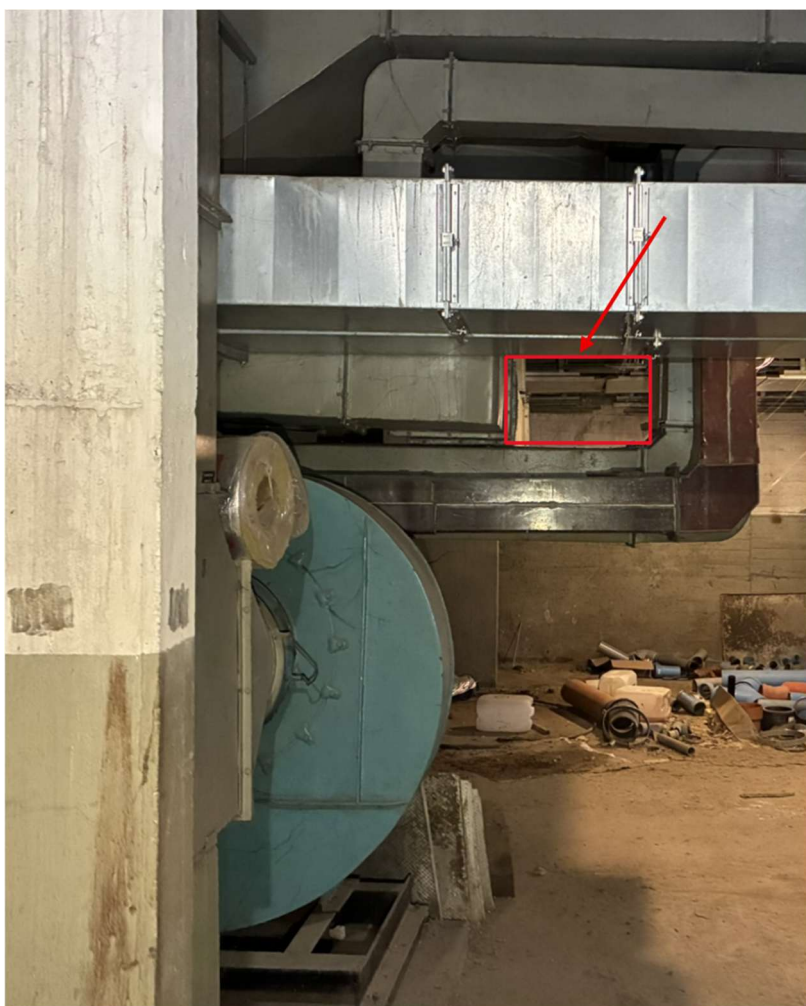
Zdjęcie 2 – Widok przestrzeni prowadzenia rur ciepłego glikolu do Nowego Topielnika Lodu.
