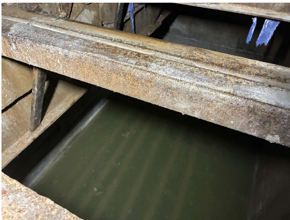
Zdjęcie 12 – Konstrukcja pokrywy topielnika – do renowacji. Widoczna na zdjęciu węzownica – do usunięcia i zastąpienia nową o analogicznej budowie.
