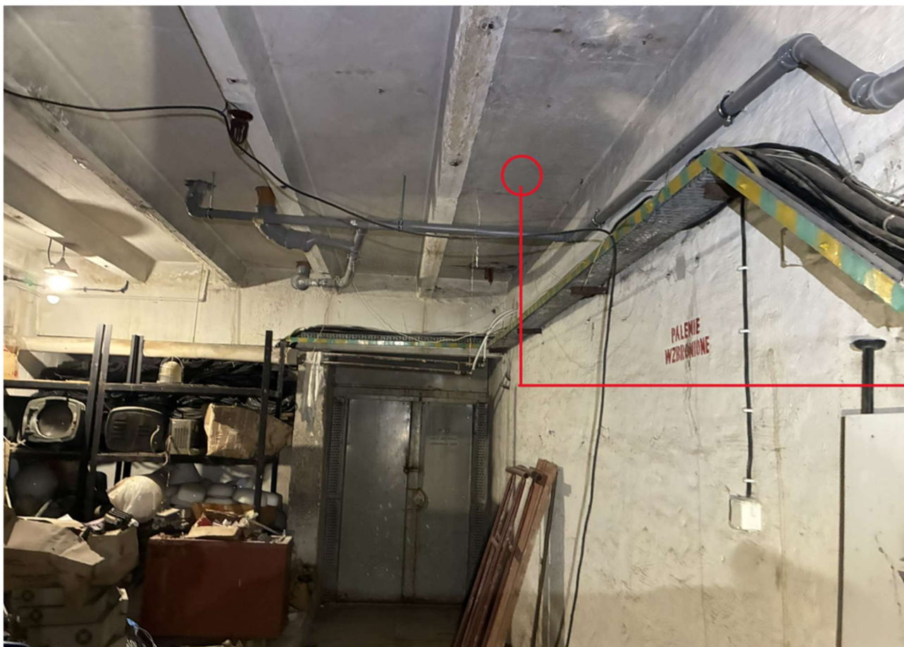
Zdjęcie 9 – Miejsce wyprowadzenia rur z Kanału Technicznego i dalsza tras W tym rejonie można usytuować (opcja) wymiennik woda/glikol i pompę pozwalającą na zasilanie nowej wężownicy z sieci miejskiej.
