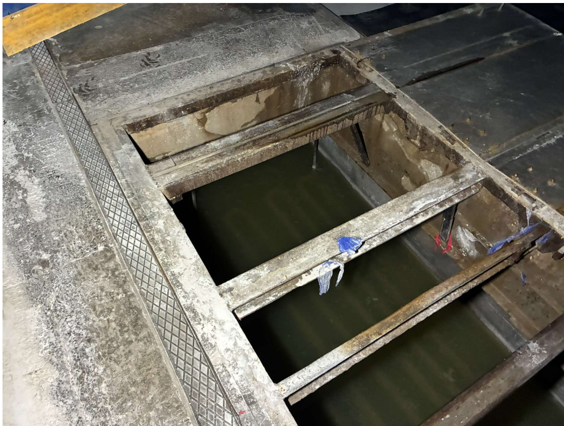
Zdjęcie 11 – Konstrukcja pokrywy topielnika – do renowacji: powłoka antykorozyjna oraz ubytki betonu
